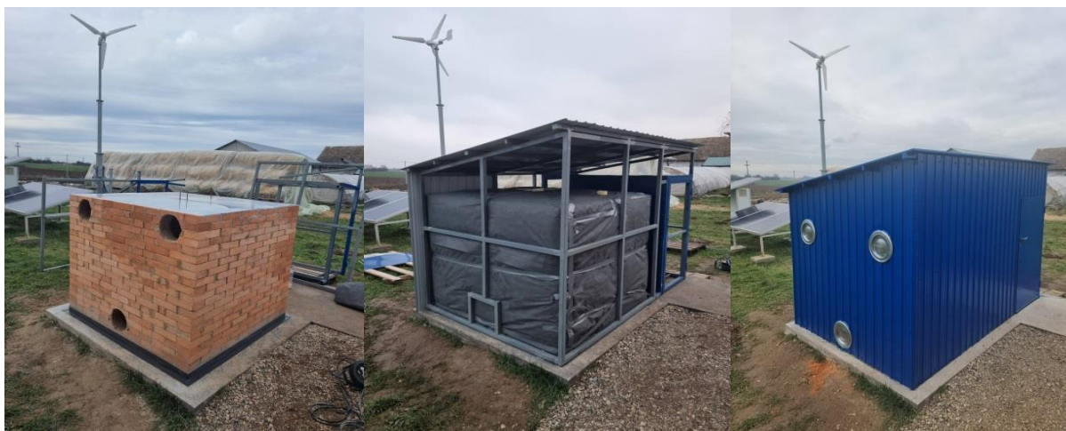
Слика 2., 3. и 4. Фазе изградње сушаре: складиште енергије од шамотних опека, термоизолација комора и коначан изглед постројења
